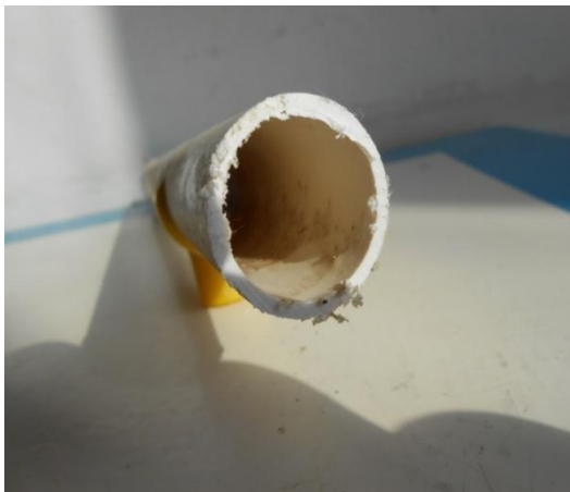
电解水消毒前管路
